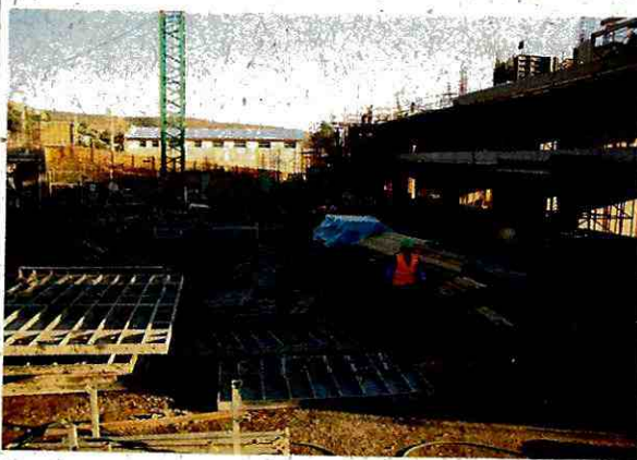
Fotografía N° 5: Placas de moldajes dispuestas sin orden en el predio de construcción.
